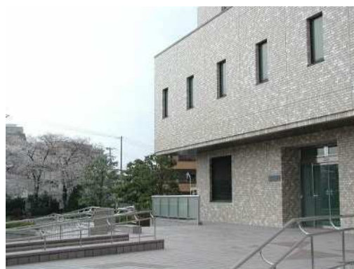
高度浄水処理棟
