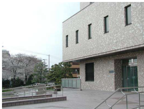
高度浄水処理棟
