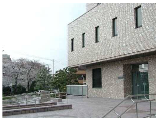
高度浄水処理棟
