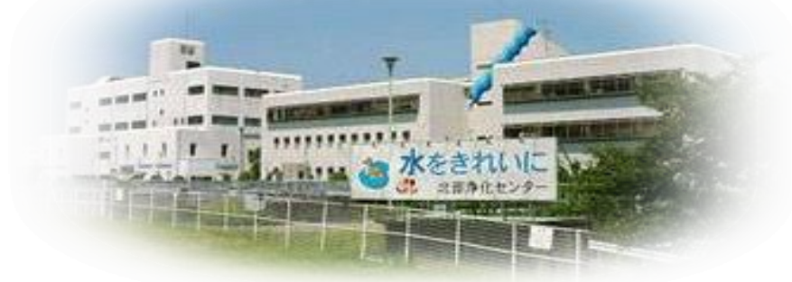
北部浄化センター
