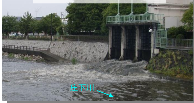
写真5 栗山中継ポンプ場からの放流の様子
