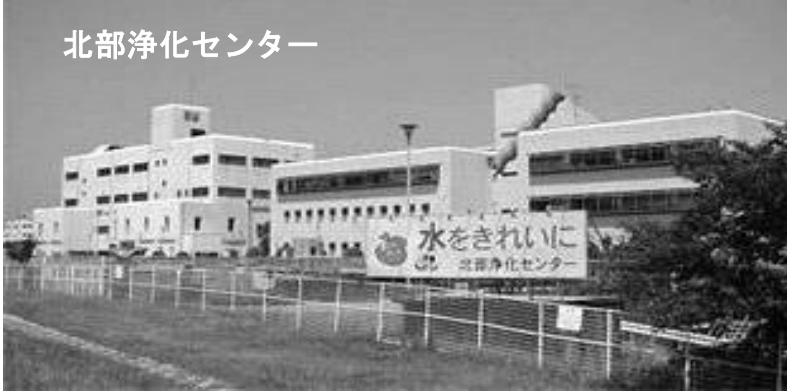
北部浄化センター
