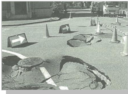
写真4 下水道管路が被災した事例
