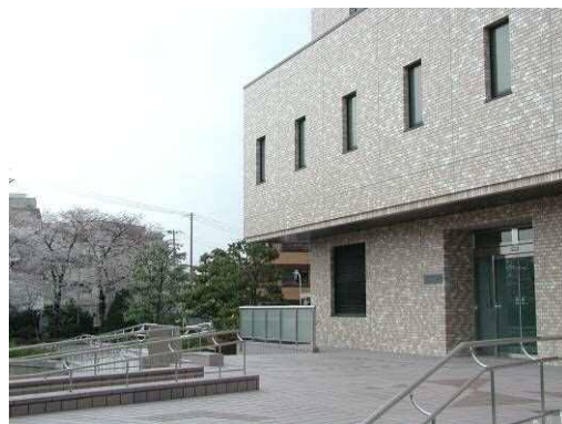
高度浄水処理棟
