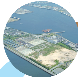
武庫川下流浄化センター
