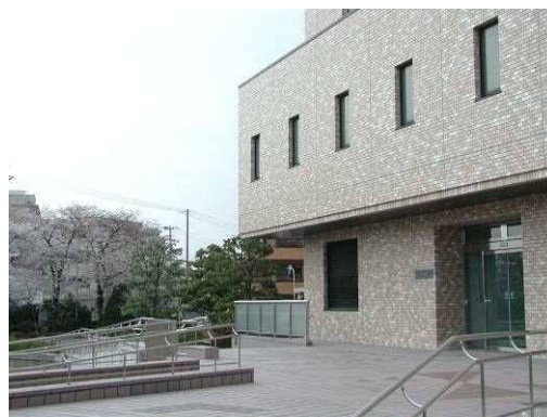
高度浄水処理棟
