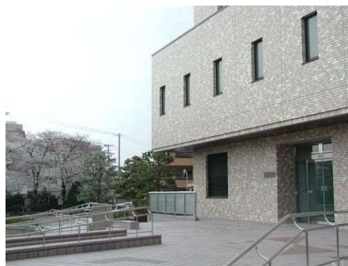
高度浄水処理棟
