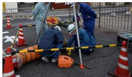
下水道管路の点検調査
