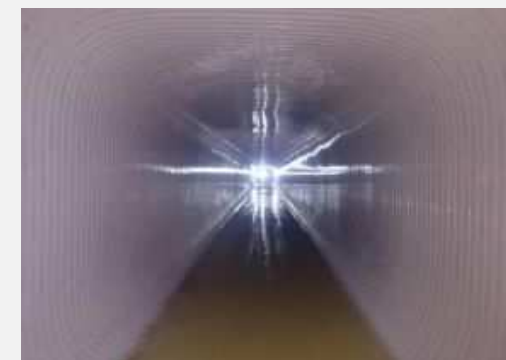
更新後の管路
