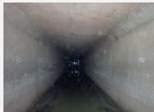
更新前の管路
