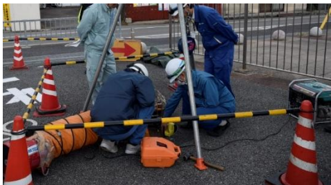
下水道管路の点検調査
