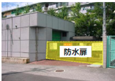
防水扉の設置による浸水対策
