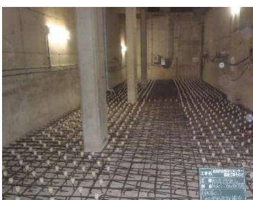
コンクリート増し打ちによる耐震化
