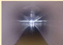
更新後の管路
