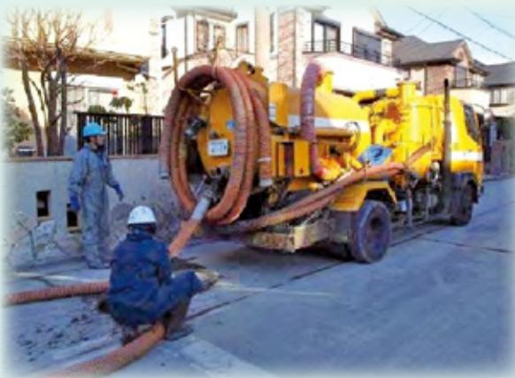
下水管路が破損し下水が流せなくなった場合は、仮の排水路を整備したり、マンホール内にポンプを設置することにより、被災していない管路へ下水を流すことができます。
