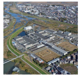
猪名川浄水場
