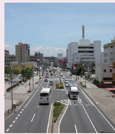
現在の国道2号
