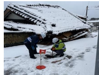
令和6年1月 能登半島地震災害派遣 (漏水調査)
