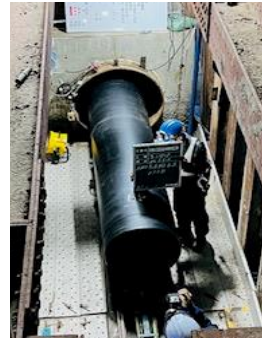
10号配水本管更新
