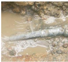
鉛製給水管からの漏水
