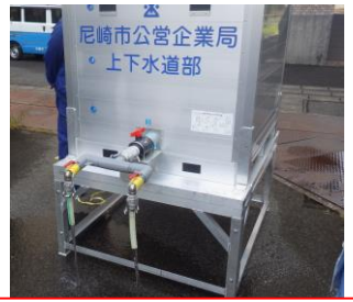
組立式給水タンクの組立及び給水拠点開設
