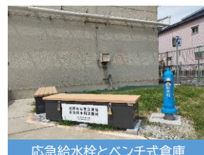
応急給水栓とベンチ式倉庫
