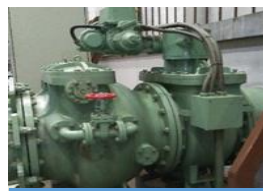
一津屋取水場吐出弁・逆止弁更新
