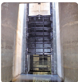
大庄中継ポンプ場の流入ゲート設備の更新
