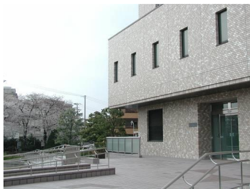
高度浄水処理棟
