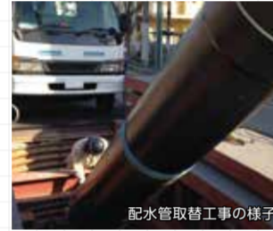
配水管取替工事の様子
