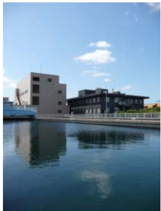
<<<神崎浄水場 沈でん池>>>
