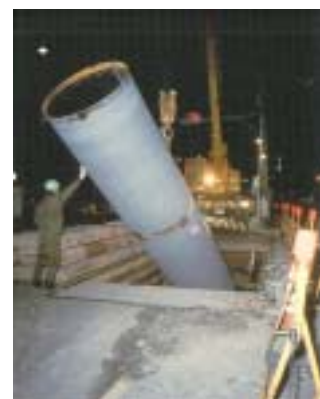
配水管の更新工事
