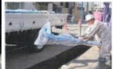
配水管更新工事
