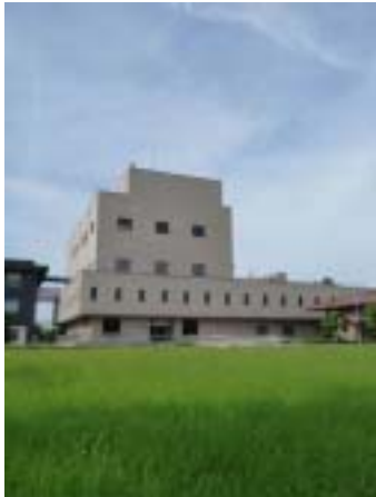
高度浄水処理棟(神崎浄水場)
