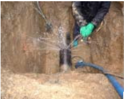
配水管の修繕工事
