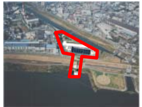
一津屋取水場 大阪府摂津市西一津屋
