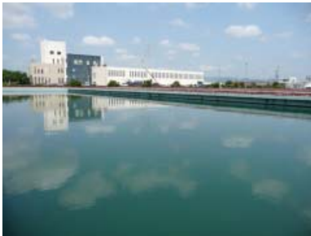
<<< 園田配水場 沈でん池>>>
