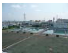
沈でん池・配水池
