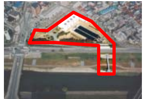
江口取水場 大阪市東淀川区北江口
