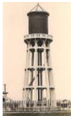
配水塔(創設工事)
