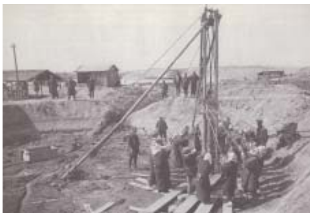
人力による神崎浄水場の創設工事
