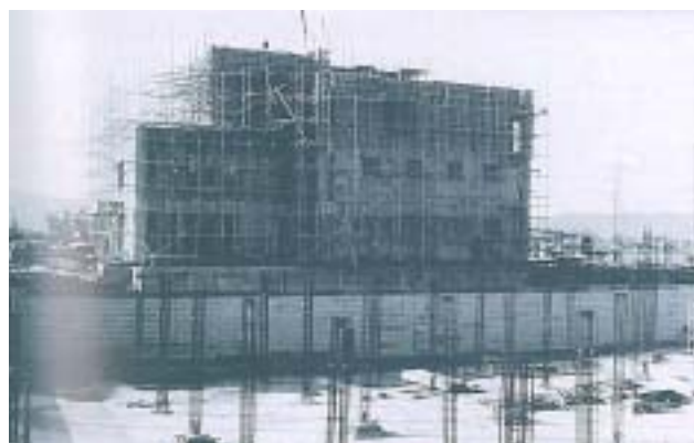
園田配水場の建設
