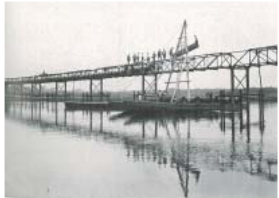
神崎川水管橋工事(第1期拡張事業)
