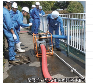
簡易ポンプによる排水訓練の様子
