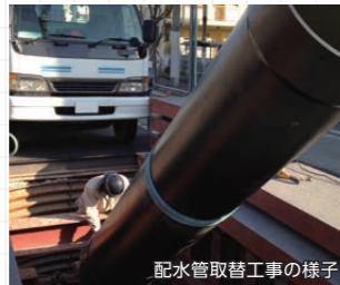
配水管取替工事の様子
