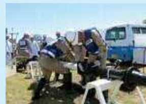
漏水した管を復旧する訓練
