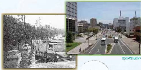
国道2号大物陸橋西詰め付近
