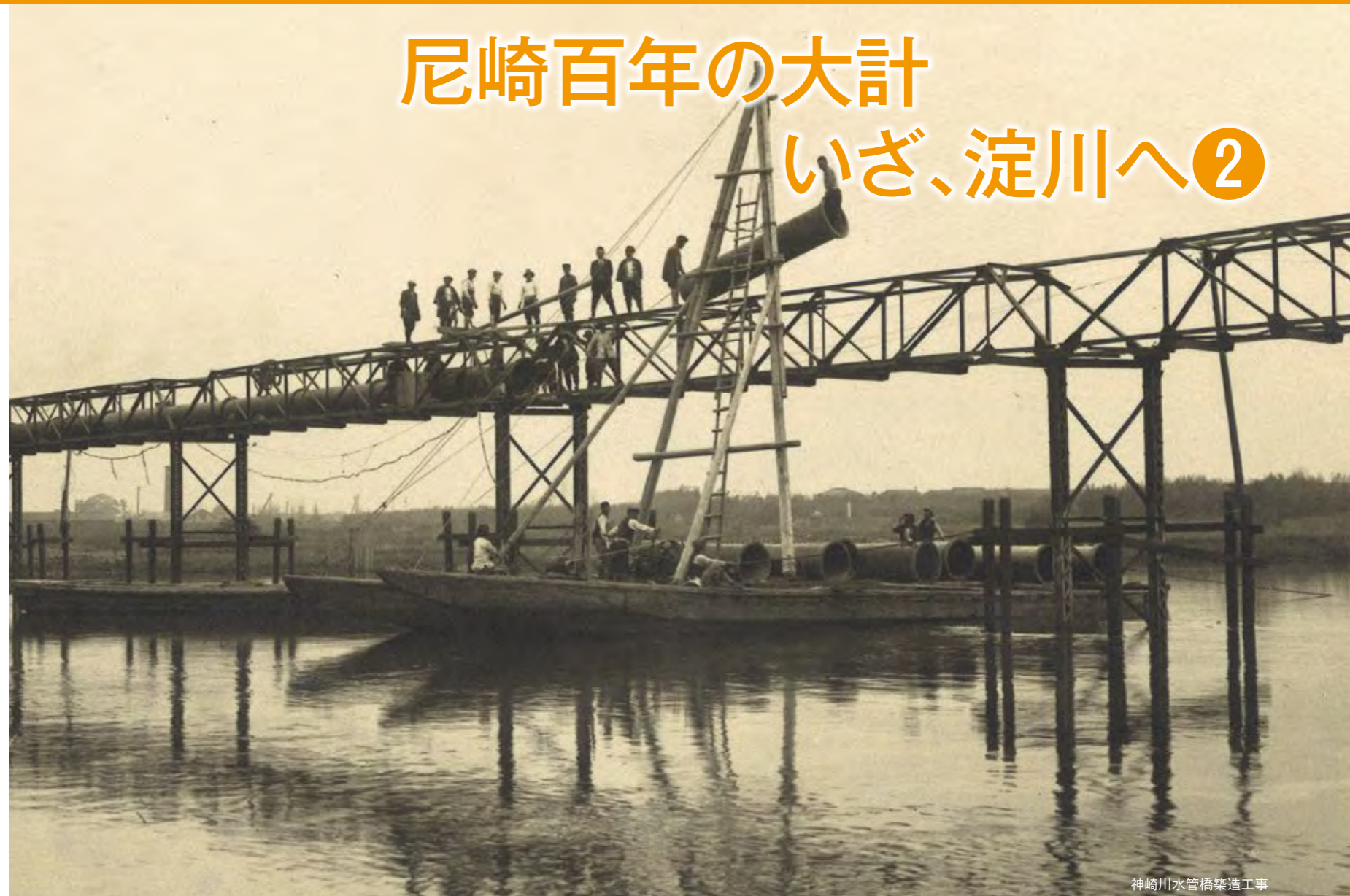
神崎川水管橋築造工事
