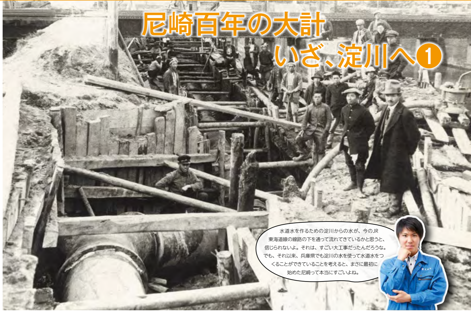
柴島取水場(淀川)から神崎浄水場までの導水管(水道管)
