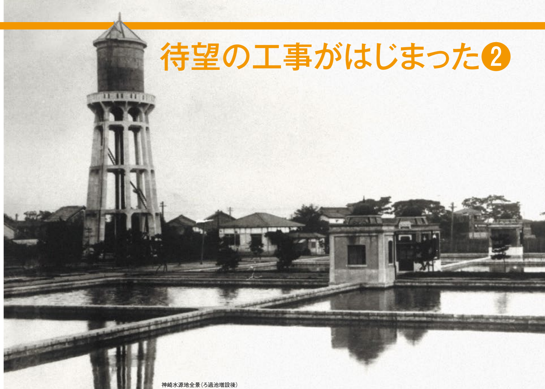
神崎水源地全景(ろ過池増設後)
