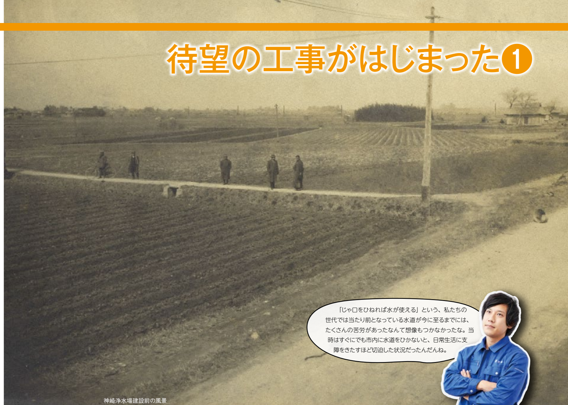
神崎浄水場建設前の風景
