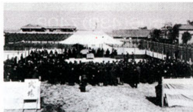
●神崎浄水場竣工式
