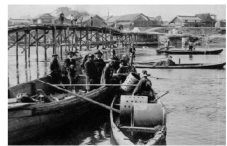
●集水管の布設
