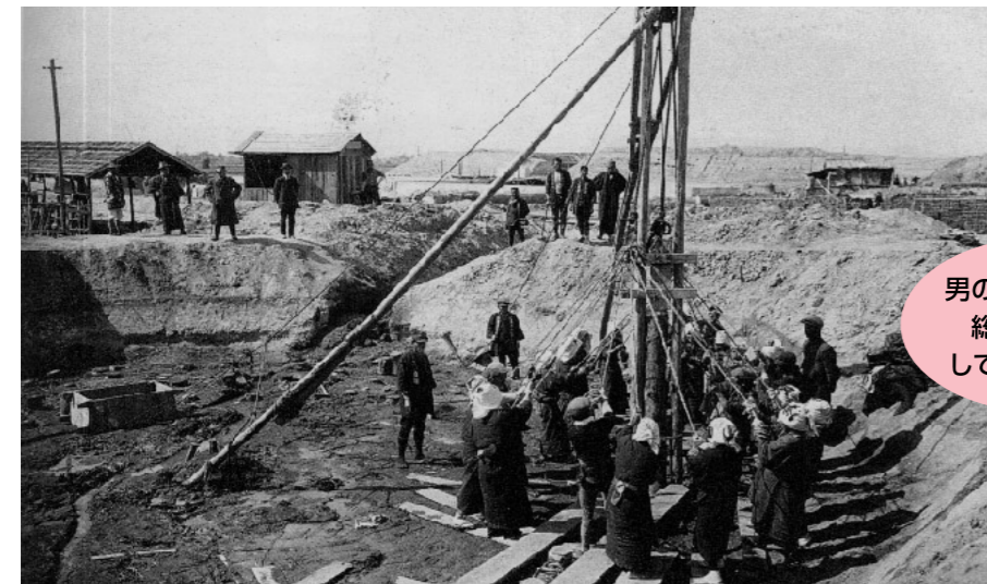
●神崎水源地（現神崎浄水場）工事風景
