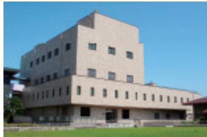
●高度浄水処理棟
