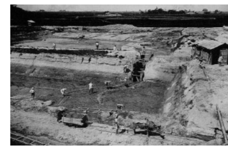
●神崎水源地（現神崎浄水場）建設工事
