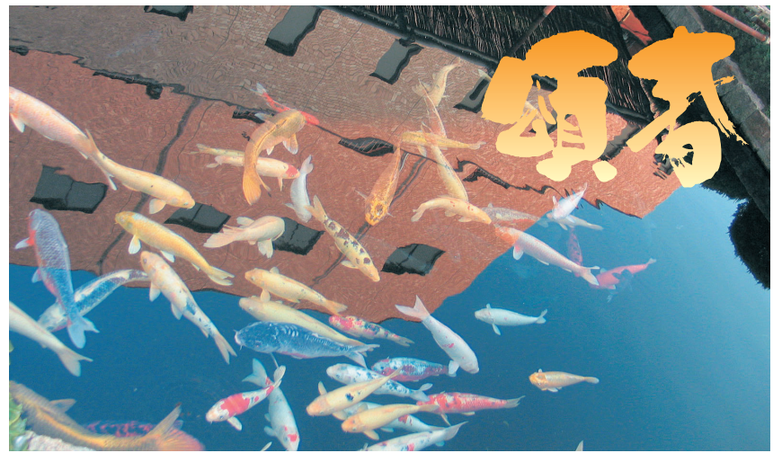
●鯉と高度浄水処理棟（神崎浄水場）
