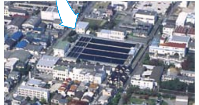
神崎浄水場沈でん池
