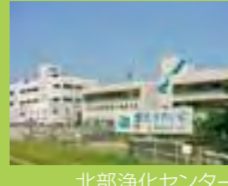
北部浄化センター
