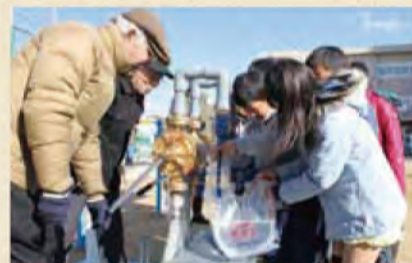
過去に耐震性緊急貯水槽を使って訓練した様子
