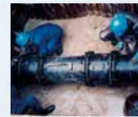
阪神・淡路大震災時の破損した水道管の復旧工事の様子
