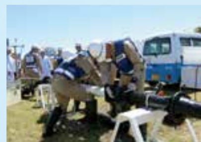
漏水した管を復旧する訓練
