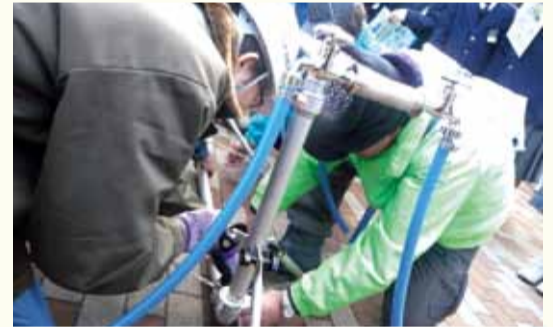
仮設給水栓の組み立ての様子(常陽中)
