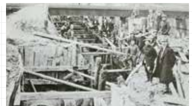
導水管の東海道線軌道下横断工事
