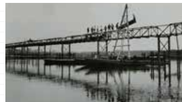
神崎川水管橋築造工事
