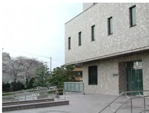
高度浄水処理棟
