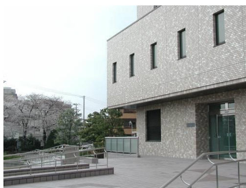
高度浄水処理棟
