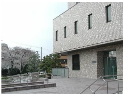
高度浄水処理棟
