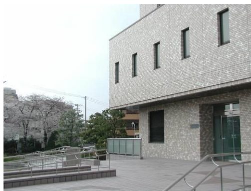
高度浄水処理棟
