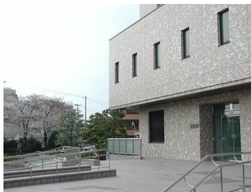
高度浄水処理棟
