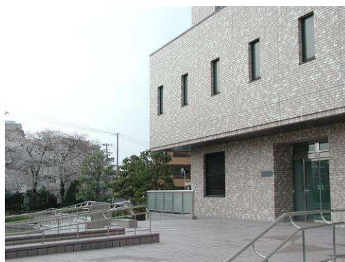
高度浄水処理棟
