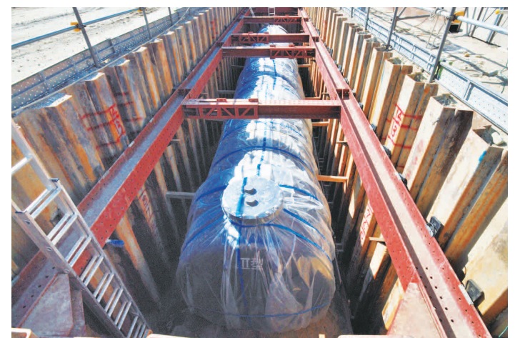
耐震性緊急貯水槽設置工事
