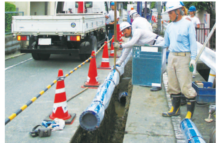
配水管更新工事
