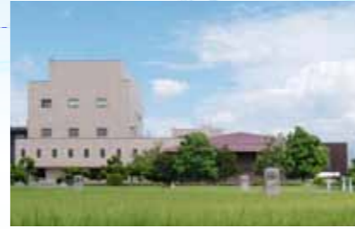
高度浄水処理棟
