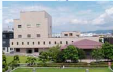
高度浄水処理棟
