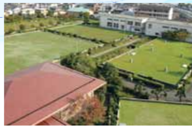
配水池とポンプ室
