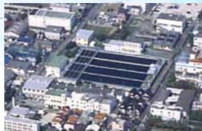
神崎浄水場沈でん池
